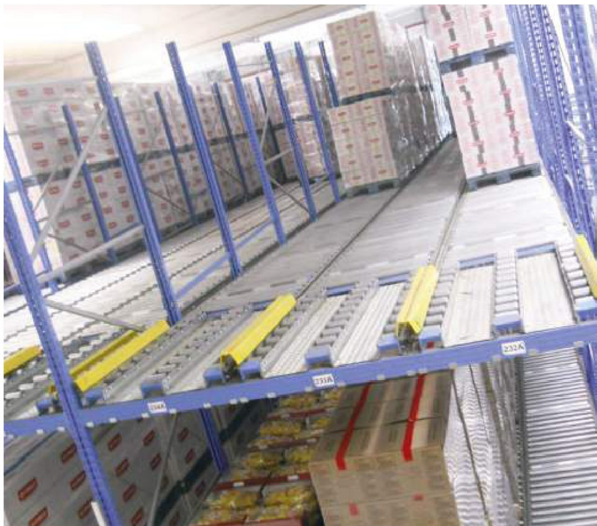
Magazzino dinamico con moduli di carico per AGV / Dynamic warehouse served by AGVs
