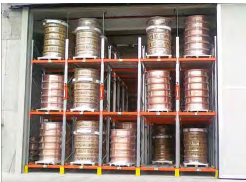
Celle di deposito attrezzate con saracinesca / Loading area with door-protected live storage
