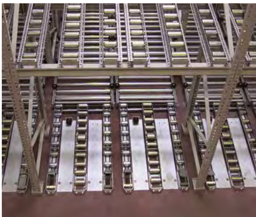
Dettaglio area di prelievo Detail picking area
