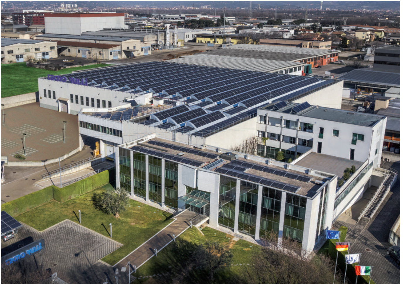
Centro di produzione principale e uffici Main production center and head office
